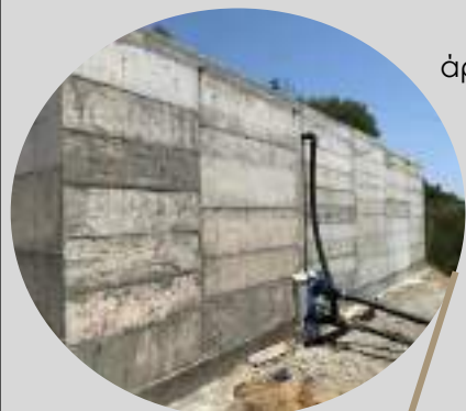
Κατασκευή δεξαμενής άρδευσης στην Κοινότητα Ρίζας 500 κυβικών
